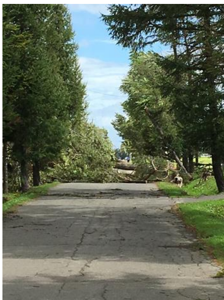
写真は、台風後の構内の様子。 木が倒れ、道路が閉鎖されていた。
